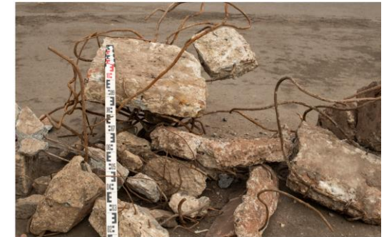
Beton mit Armierung
